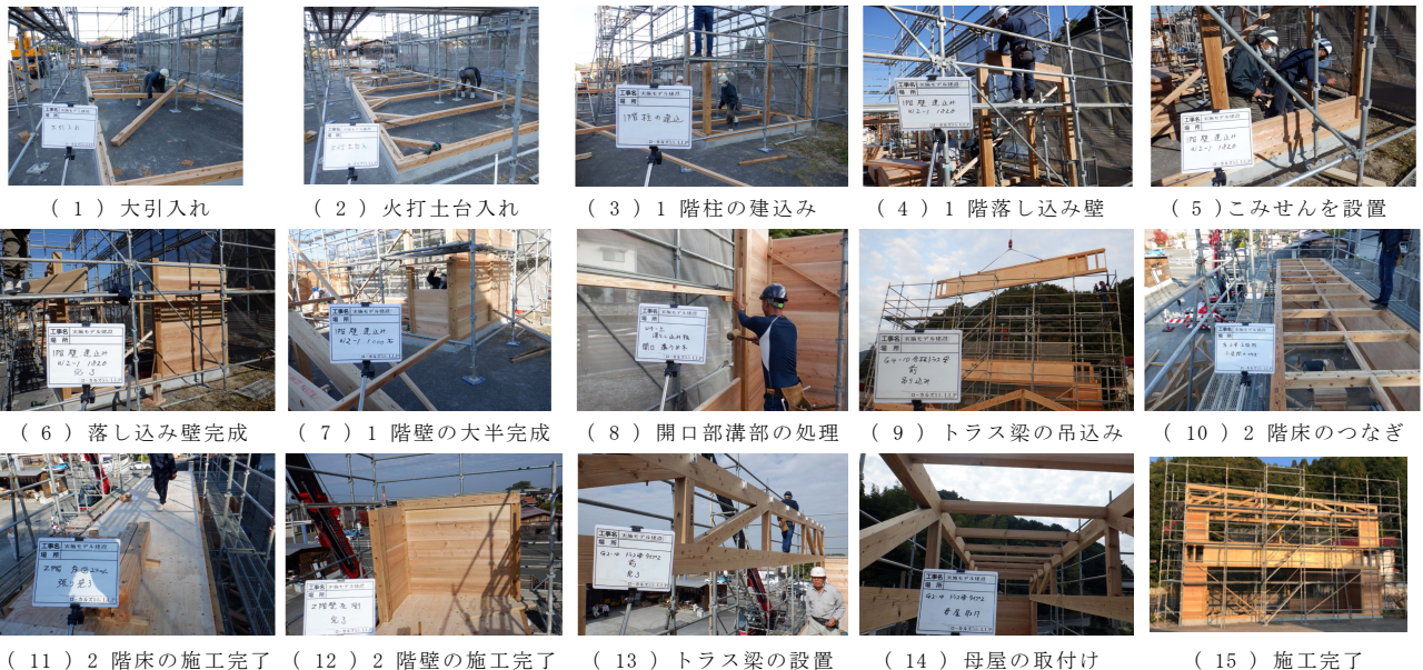
写真 1 仮設建築物の施工状況
