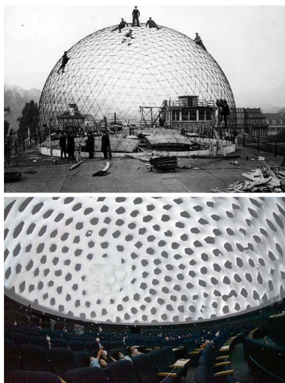
図1. 1922年にイエナのツァイス工場の屋上に建設途中のプラネタリウムドーム（上／Photo: Courtesy of ZEISS Archives）と，2020年のイベントでプラネタリウムに映し出した放散虫骨格（下／3Dデータは岸本直子氏提供）．
