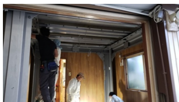
写真 3. 実施例施工中
