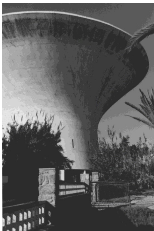
図2 Fedala の給水塔
