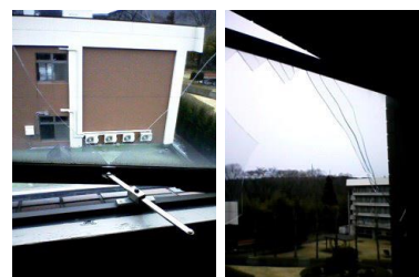
(a) (b) 図7 片開き窓硝子の割れ目
